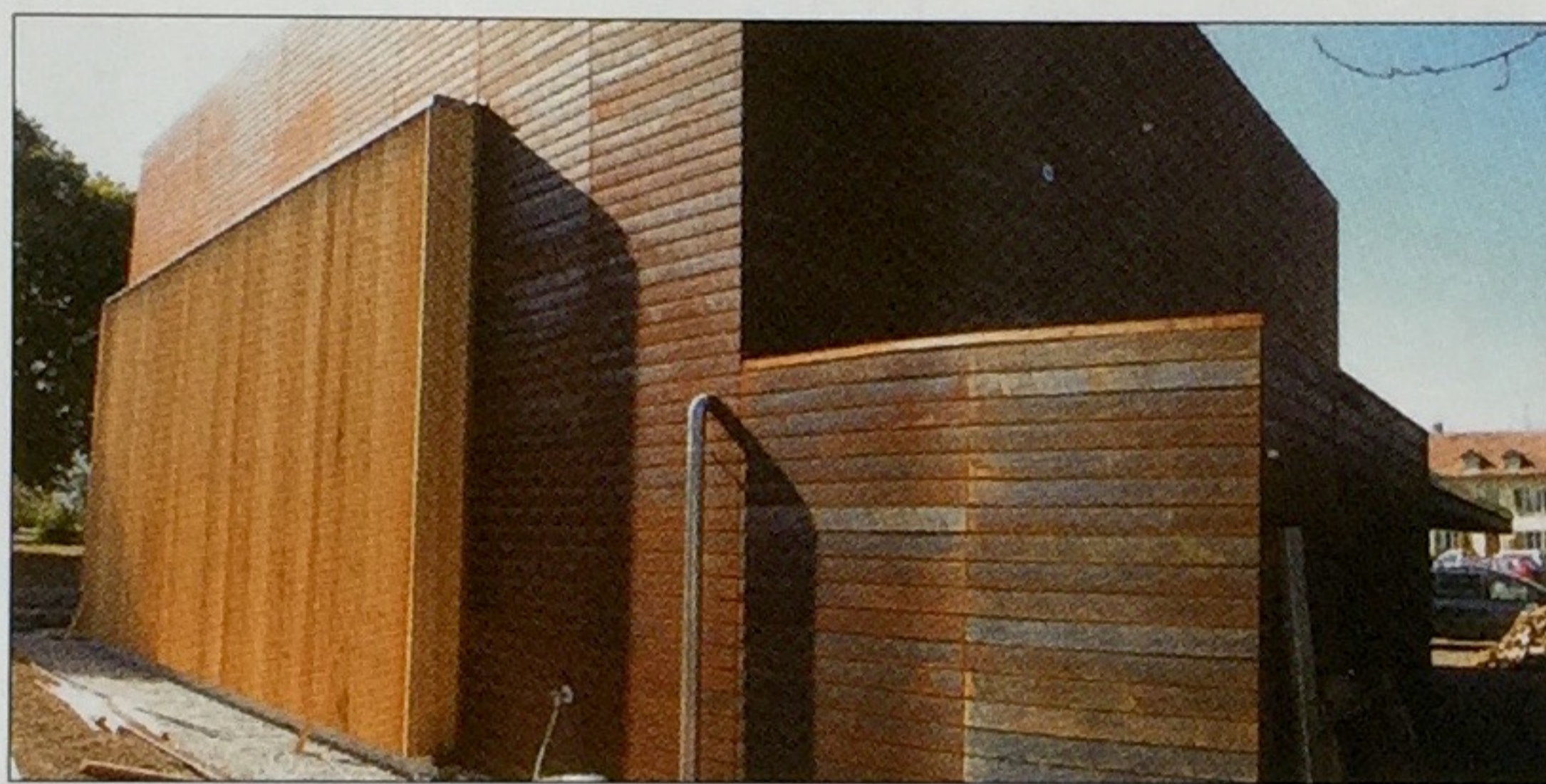
Matérialisation extérieure: acier cortène, mélèze naturel.
