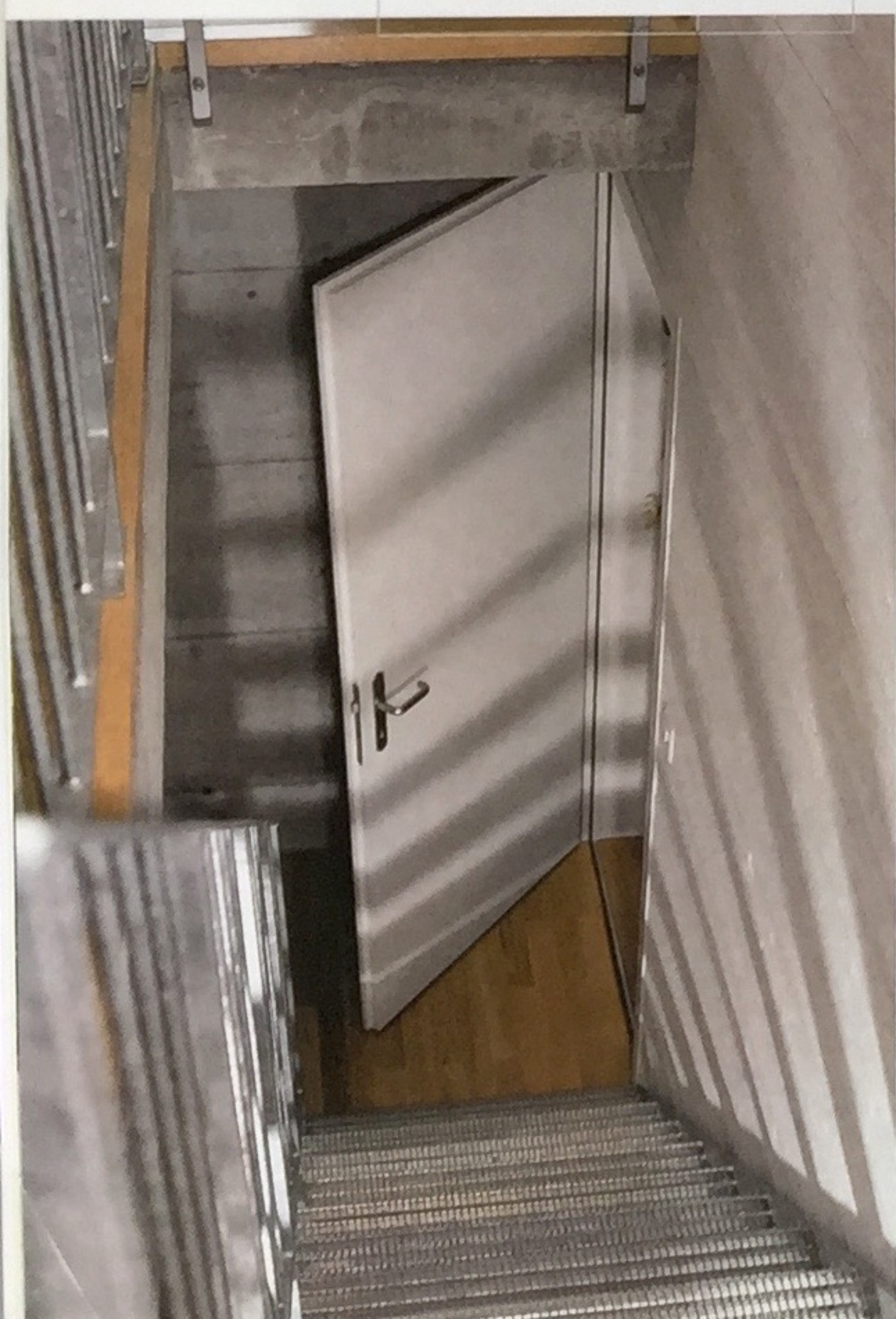
L'escalier industrielle en métal ...
