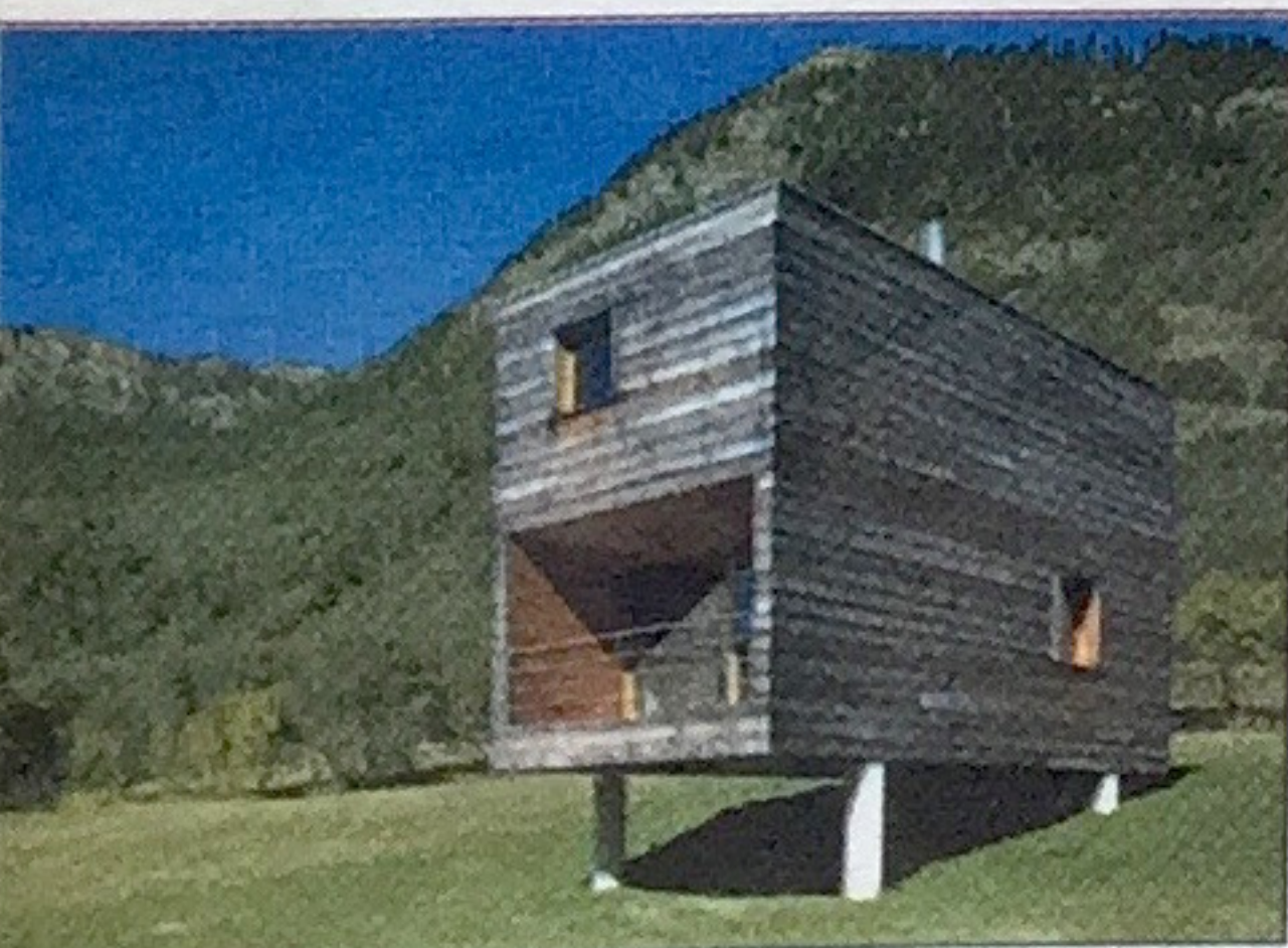
Maison de vacances à Campo Vallemaggia (TI), une idée de l'architecte Roberto Briccola réalisée en un mois par un charpentier local. (SOURCE: B. COUNSON)
